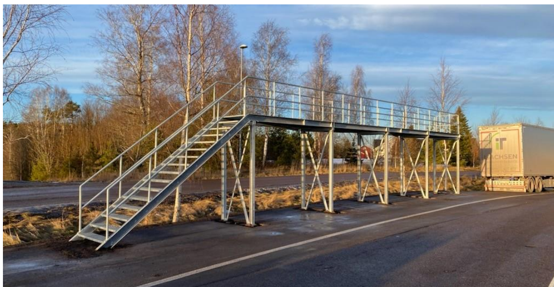
En av de nye snørampene som er på plass i Vestfold. Her på Gulli som er en viktig omlastingsplass utenfor Tønsberg er dessuten plassen utvidet og oppgradert.
