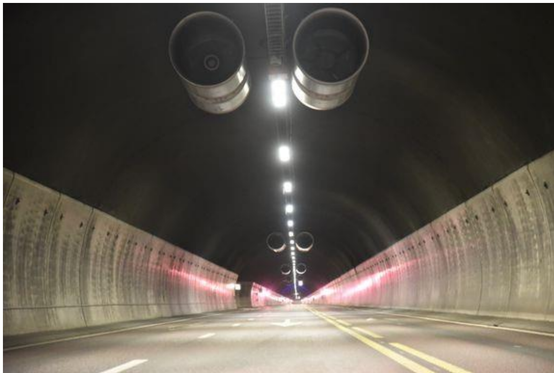
Ny ventilasjon i Oslofjordtunnelen er bare ett av mange sikkerhetstiltak som gjør at tunnelen nå kan være åpen for alle typer kjøretøy 24 timer i døgnet. Foto: Anine Kalmo Larsen / Statens vegvesen.
